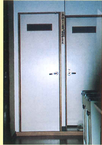
参集殿トイレ改修
