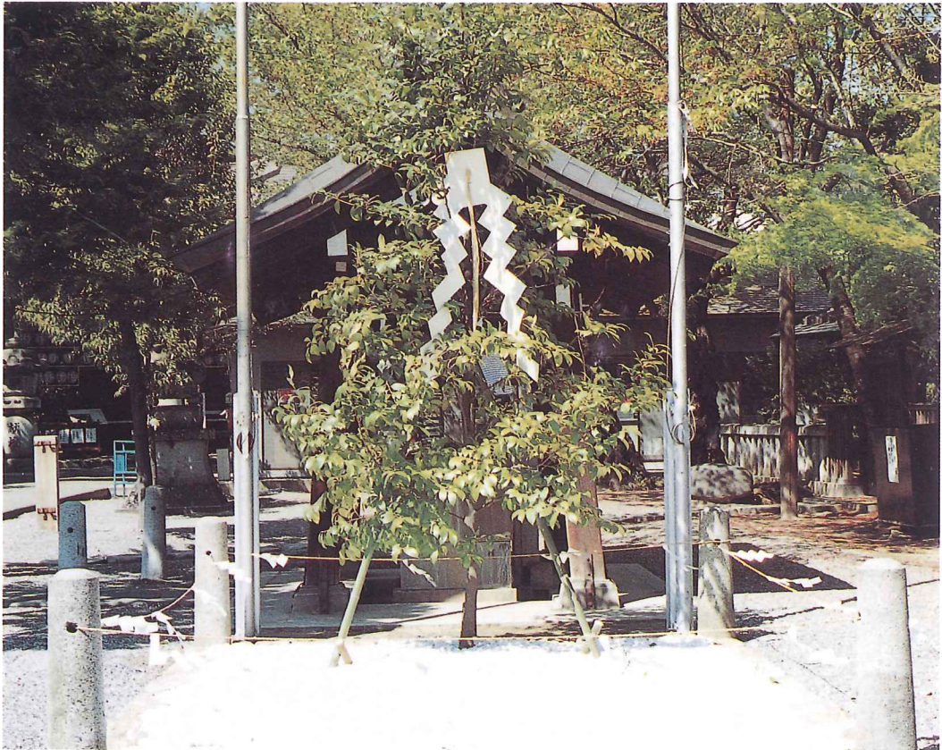
新設された祓所
